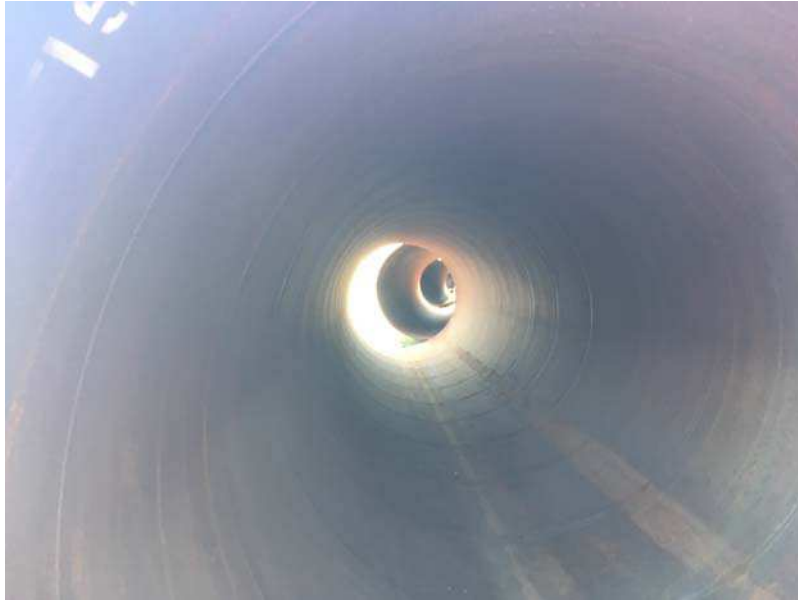
ფოტო 11. მიღების დიამეტრის 2.4 მ-დან 1.7 მ-მდე შემცირებით წყალაღების საპროექტო ხარჯი (9 მ 3 /წმ) ორჯერ შემცირდებოდა, რაც „ეკოლოგიური ხარჯს“ მნიშვნელოვნად გაზრდიდა და იქთიოფაუნის ინტერესის გარდა ბირკიანის და დუისის წყალმომარაგებასაც უზრუნველყოფდა მდინარის და არა ჰესების ნამუშევარი წყლით.
