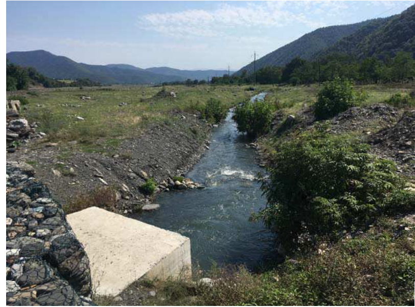
ფოტოები 5 და 6. ალაზნის საირიგაციო არხის სათავე ნაგებობის ზედა და ქვედა ბიეფი სოფ. ბირკიანთან (სათავე ნაგებობის ფოტოსურათი არ არის გზშ-ში მოყვანილი. ამასთან, აშკარად ჩანს, რომ წყალაღების ხარჯი მნიშვნელოვნად აღემატება დოკუმენტში შეფასებულ მნიშვნელობას, ციტატა „მერყეობს 0.06-0.08 მ 3 /წმ-ის ფარგლებში“).
