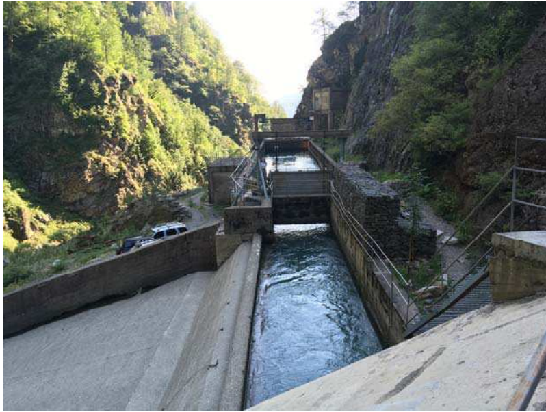
ფოტო 32. მდ. სამყურისწყალზე ხადორი-1 ჰესის წყალაღება 100-პროცენტია, ხოლო „ეკოლოგიური ხარჯი“ 0-ის ტოლი.
