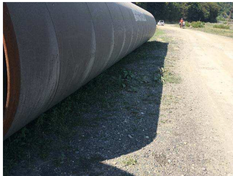
ფოტო 10. მილები არასათანადოდაა დასაწყობებული, არსებობს დაგორების და ადამიანების სასიკვდილოდ დაზიანების საფრთხე.
