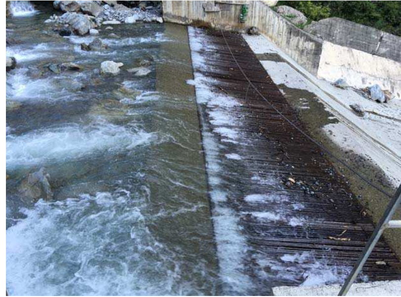
ფოტო 31. მდ. სამყურისწყალის დინება მთლიანად არის ჩაჭერილი და მიმართული ჰესის ტურბინების მკვებავი სადერივაციო გვირაბისკენ.
